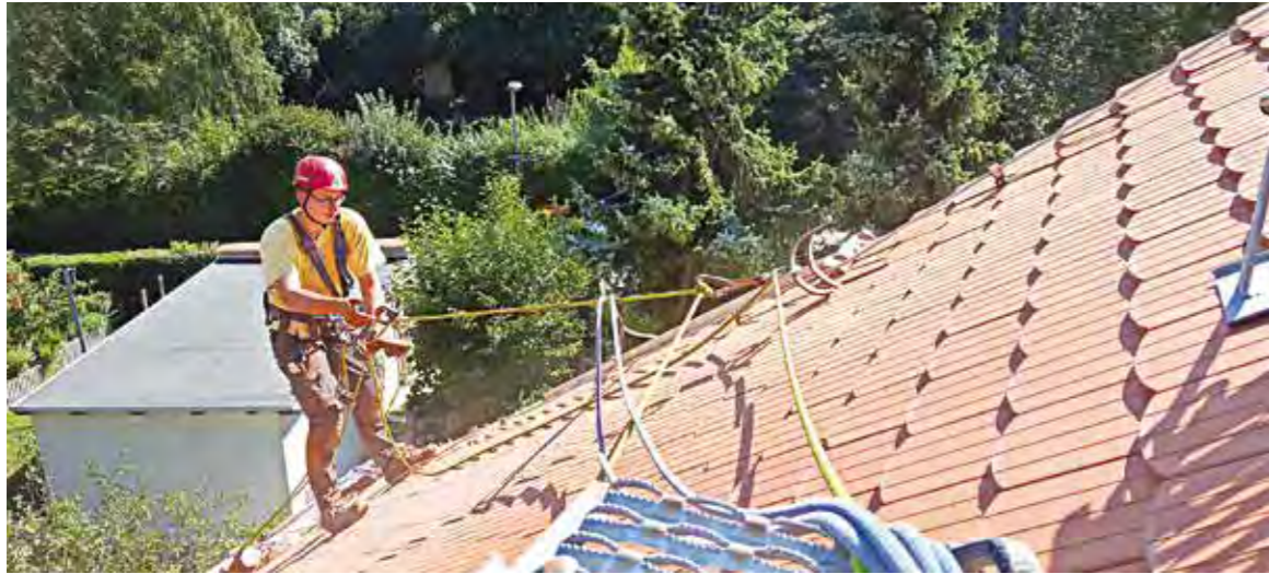
Dachdeckermeister und Seilkletterer Andy Hüller bei der Arbeit auf dem Dach.
