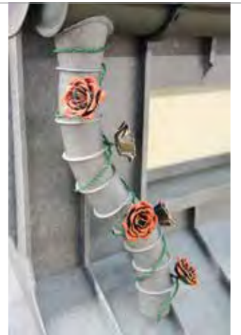
Ein gefalzter Schwanenhals mit zusätzlicher Rosenranke.
