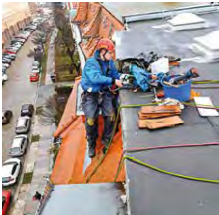
Hochkonzentriert bei Reparaturarbeiten an einer Gaube.
