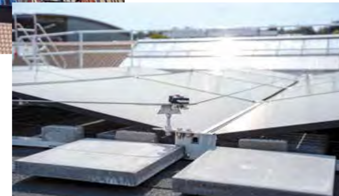
Eine Dachfläche mit Photovoltaikmontagesystem und integriertem Seilsicherungssystem.
