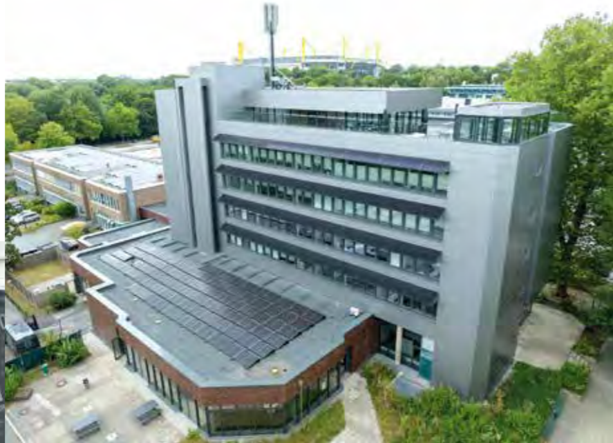
Handwerkskammer Dortmund: 2292 Quadratmeter Fassade sichtbar genietet in Alucobond, Eckausbildung teil- weise gerundet
