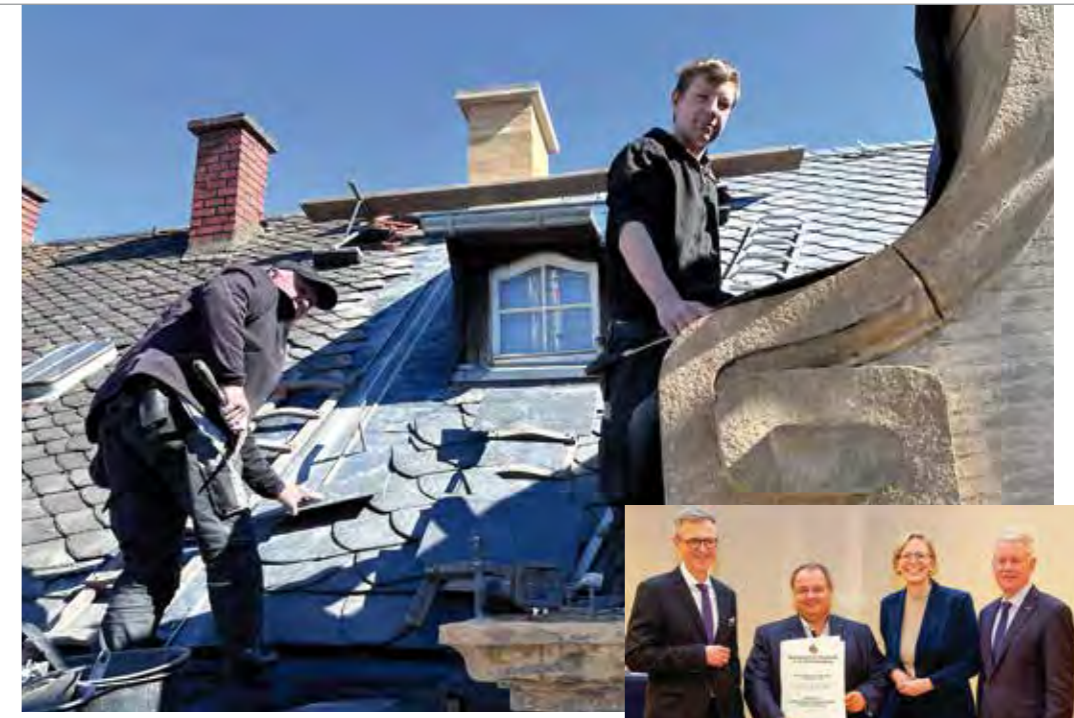
Mitarbeiter sanieren ein altes Schieferdach.
