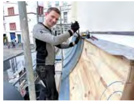
oben: Steildacheindeckungen mit Schiefer sind ein wichtiger Bestandteil des betrieblichen Leistungsspektrums.
