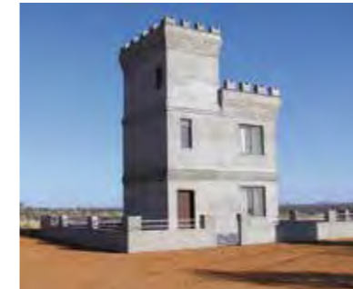
Ein von Thullesen in Namibia geplantes und gebautes Haus
