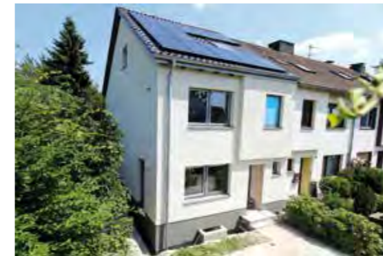
Das Einfamilienhaus in Köln-Dellbrück vor, während und nach dem Sanierungssprint
