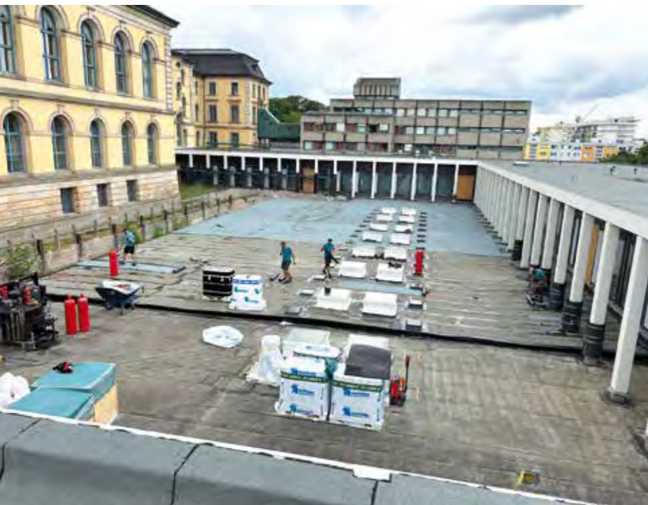
Große Flachdachprojekte sind ein Geschäftsfeld von Dach Schneider.
