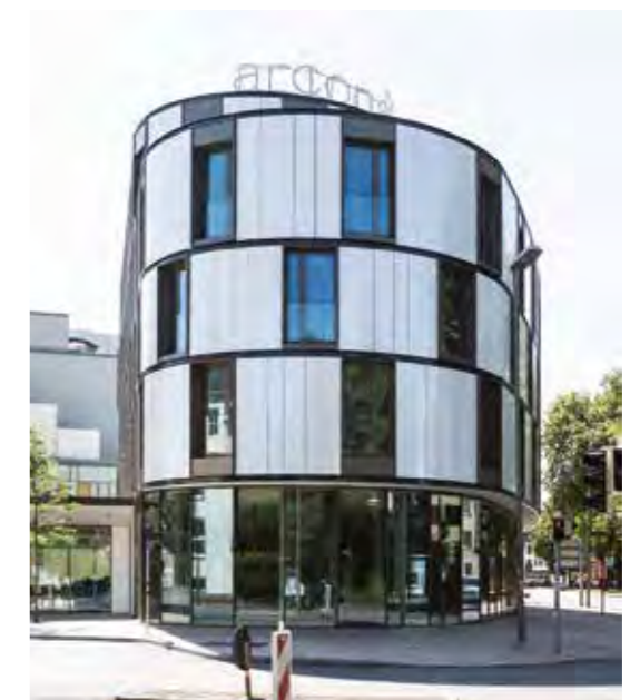
Hotel an der Osnabrück-Halle in Georgsmarienhütte: Alucobond-Kassetten, rundgezogenes Gestimsband
