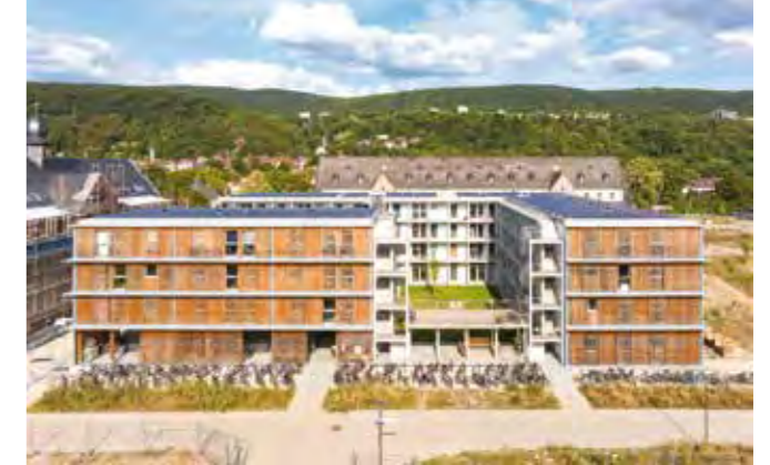
Ein rückbaubares Studierendenwohnheim in Holzbauweise
