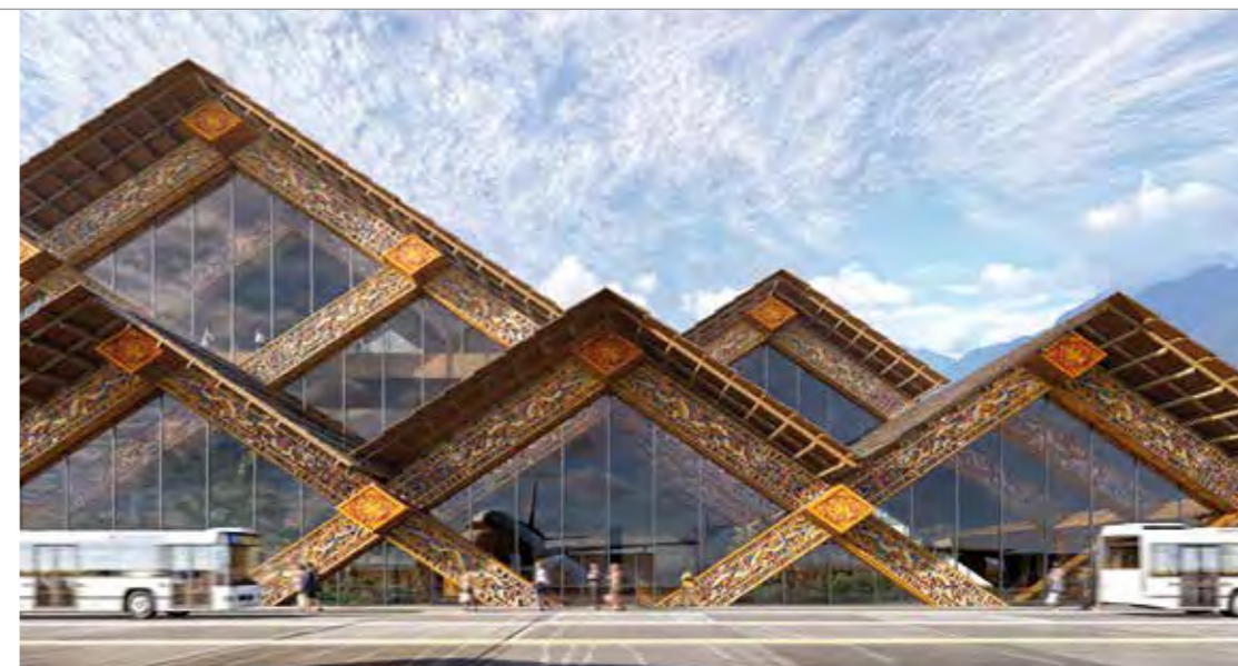
Die diagonale Struktur des Flughafens wird aus lokalem Holz gefertigt und ist mit traditionellen bhutanischen Holzschnitzereien verziert.
