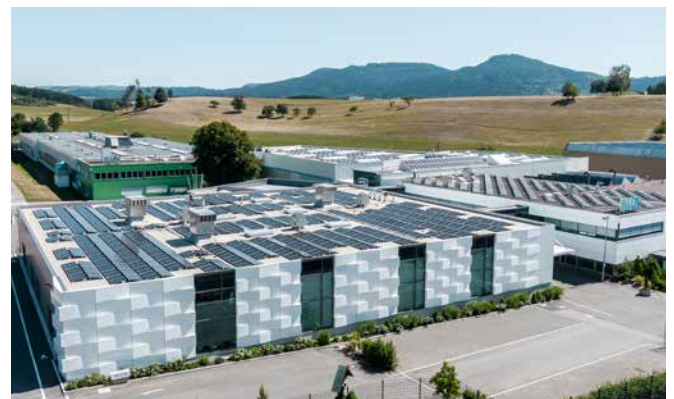
Das Team der Haller Gruppe produzierte die Alucobond®-Kassetten in eigener Fertigung.
