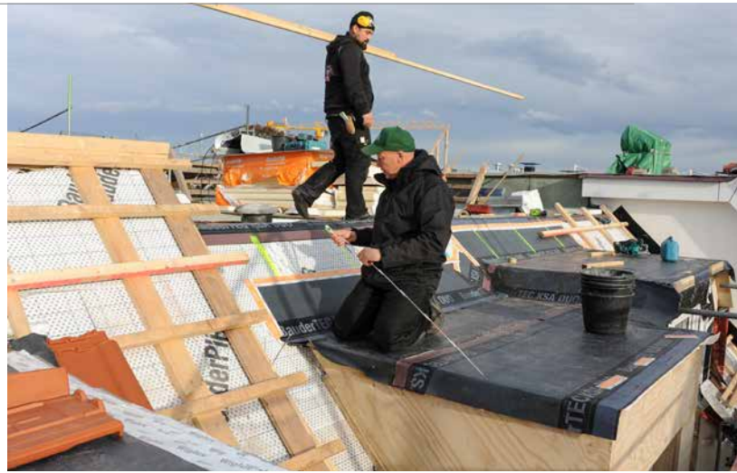
Die energetische Dachsanierung im Bestand bleibt das Kerngeschäft der Dachdecker.
