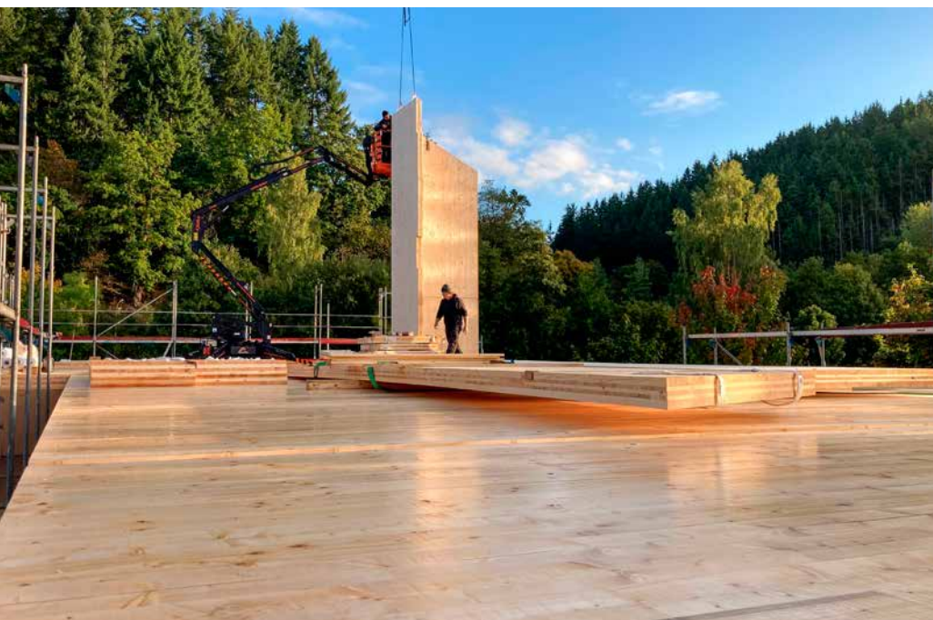
Bereits nach zehn Tagen Montage stand das komplette Gebäude.
