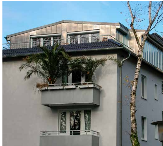
Auch Metallfassaden gehören zum Arbeitsbereich des Betriebs.
