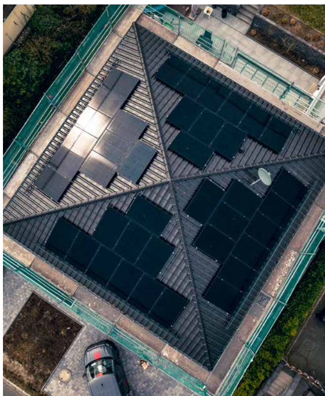
PV-Anlagen bleiben weiter ein lukratives Zusatzgeschäft für Dachdeckerbetriebe.
