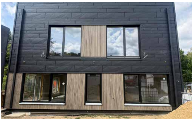
Die moderne und markante Außenfassade des Mehrfamilienhauses in Hellenthal.
