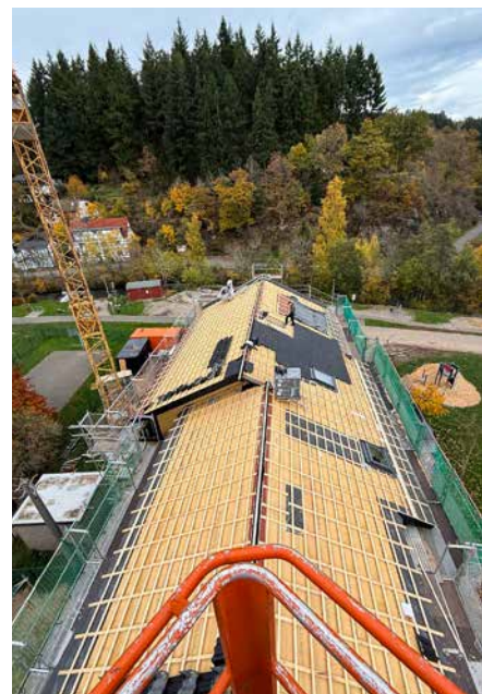
Zum Abschluss deckt das Team das Dach ein.
